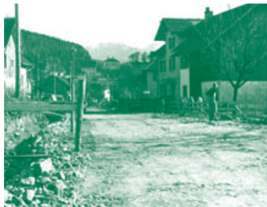
Im März 1955 wurde mit den Arbeiten begonnen. Hier ein Blick Richtung Ortszentrum, rechts das Haus Nr. 204 (Montfortstraße 13).
